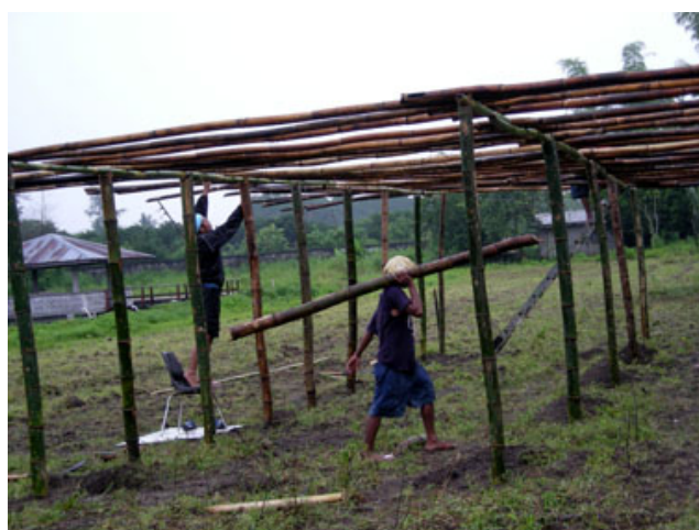
苗床の設置作業の様子
