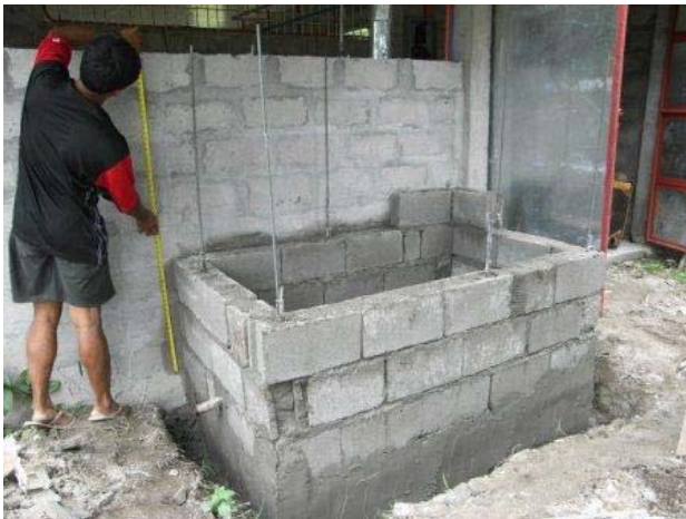
貯水タンクを作成中のクリーニングスタッフ
