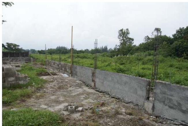
建設途中の壁基礎と柱
