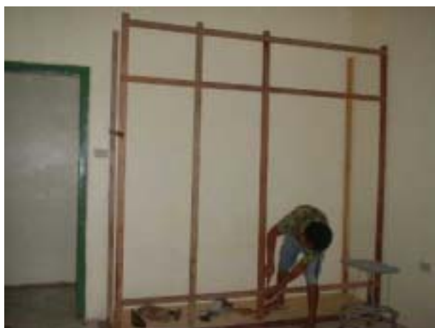
旧男子寮の内装作業の様子
