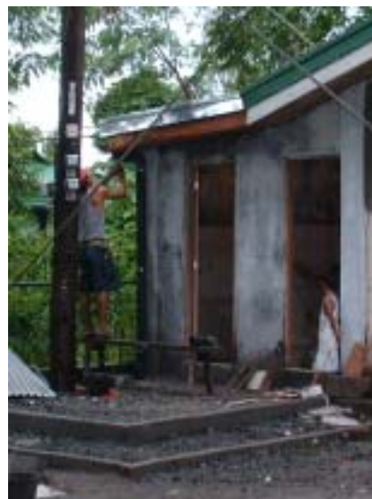
町内ホール改修作業の様子
